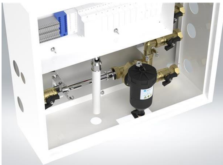
Rysunek 14: Moduł AMB z wybitymi otworami
